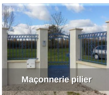
Maçonnerie de muret
